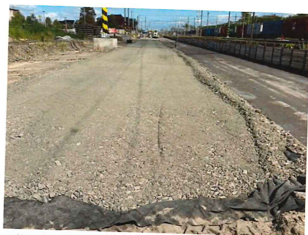
UČS 02, Sypanie a hutnenie kameniva, železničný spodok
