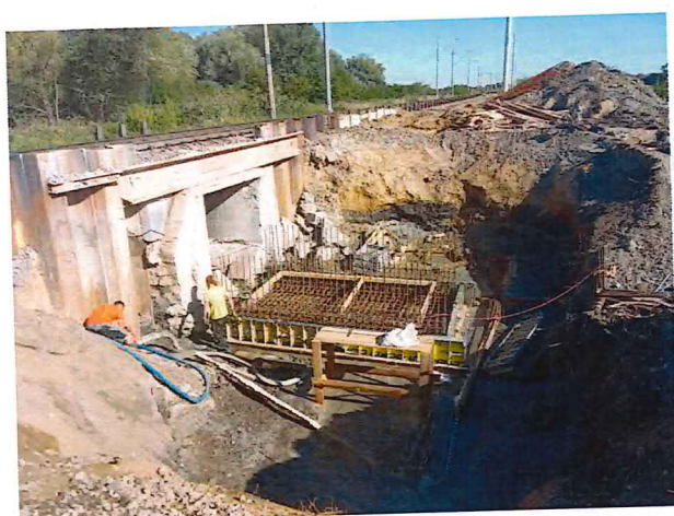
UČS 01, Armovanie, debnenie a betonáž základov, most 16
