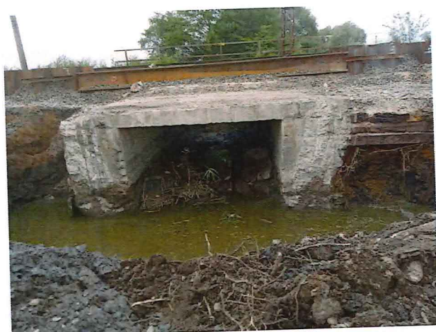
UČS 01, Čerpanie vody a armovanie rozšírenia opôr, most 15
