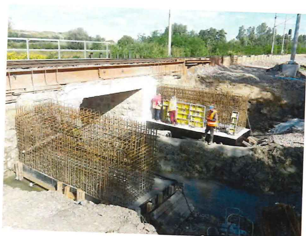
UČS 01, Armovanie a debnenie opôr, most 12
