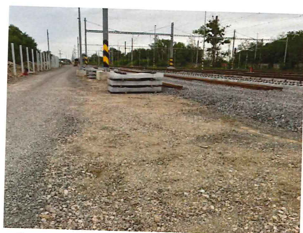
UČS 02, Sypanie kameňa a kladenie podvalov
