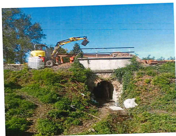
UČS 01, Inštalácia horizontálnych štetovnic, priepust 03
