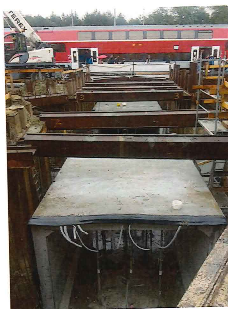
UČS 02, Betonáž stien a strop, podchod
