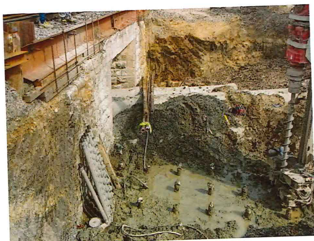
UČS 01, Realizácia mikropilót, most 12
