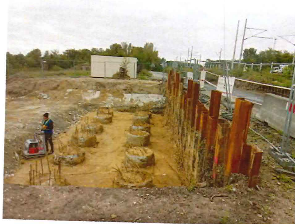
UČS 01, Realizácia pilót, odkopy a hutnenie lôžka pre základ, most 06
