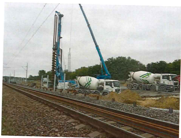
UČS 01, Realizácia pilót, odkopy a hutnenie lôžka pre základ, most 06
