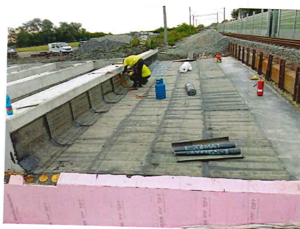
UČS 11, Izolácia mostovky, podjazd
