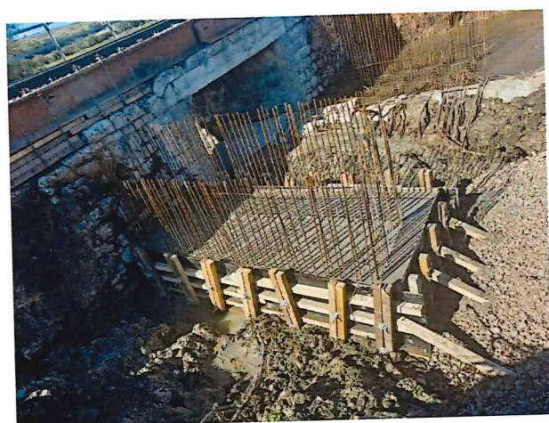
UČS 01, Armovanie, debnenie a betonáž základov mosta, čerpanie vody, most 12
