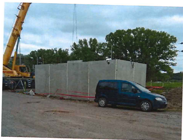
UČS 01, Montáž prefá, technologický objekt
