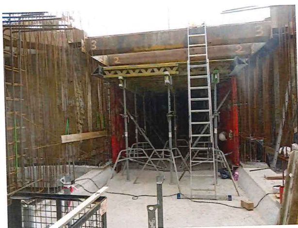
UČS 02, Armovanie a debnenie stropu a podkladovej dosky schodísk, podchod
