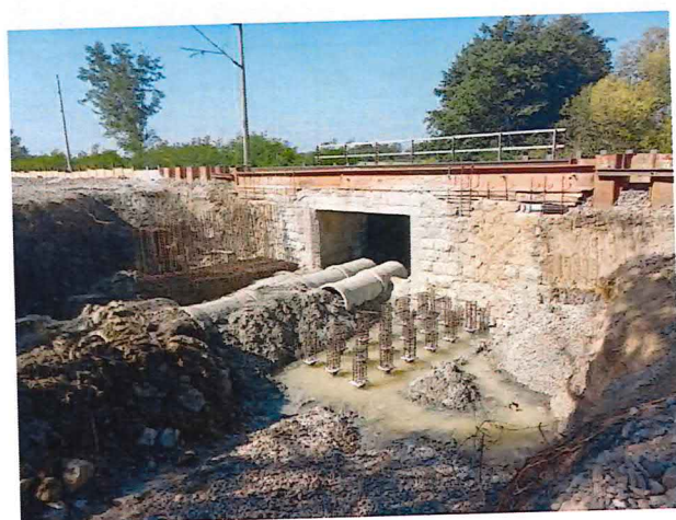
UČS 01, Realizácia mikropilót, most 12
