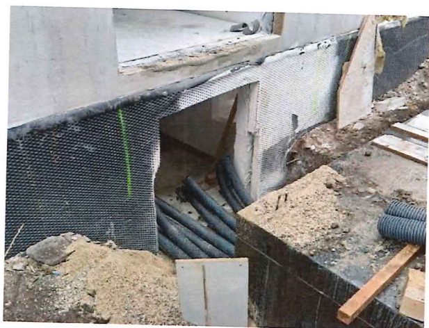
UČS 10, Zaústenie kábelovej trasy do technologického objektu
