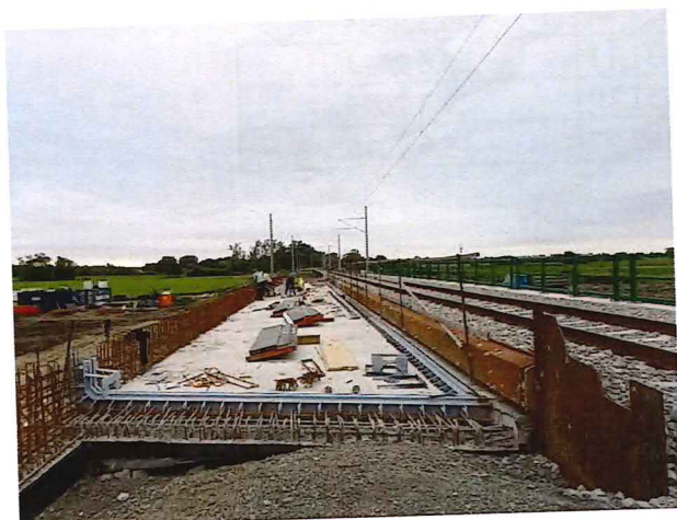
UČS 12, Montáž mostných záverov
