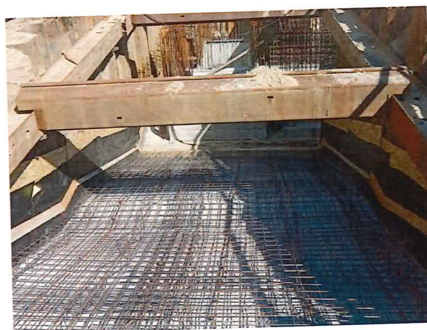
UČS 02, Armovanie a debnenie stropu a podkladovej dosky schodísk, podchod
