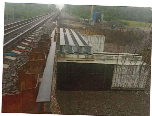
UČS 01, Ukladanie oceľových nosníkov mostovky, most 12
