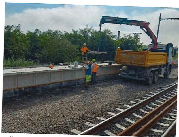
UČS 11, Montáž konzolových dosiek, nástupisko
