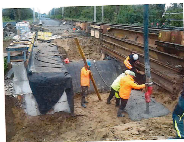
UČS 01, Armovanie, debnenie a betonáž rímsoy, prechodové oblasti, priepust 03
