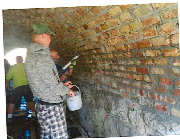
UČS 01, Búracie práce a sanácia pôvodnej konštrukcie, priepust 3
