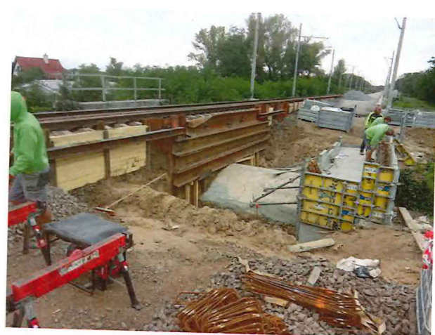
UČS 01, Armovanie a debnenie rímsy, hydroizolácia, priepust 03
