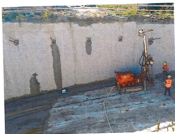
UČS 11, Realizácia mikropilót, podjazd
