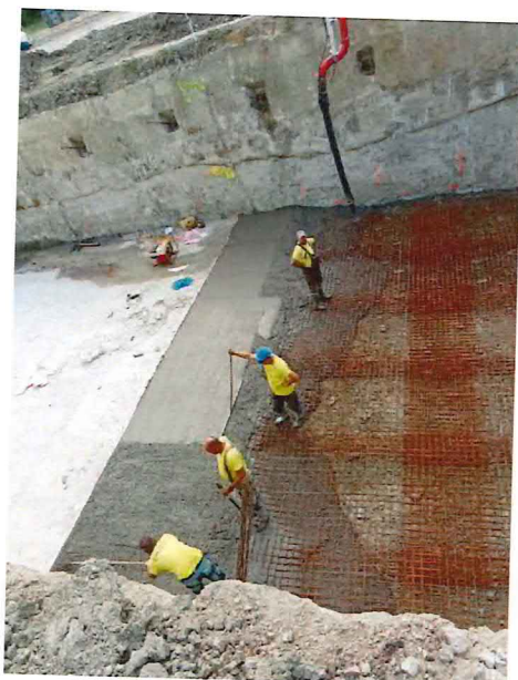
UČS 11, Betonáž podkladovej dosky a výkopy, podjazd
