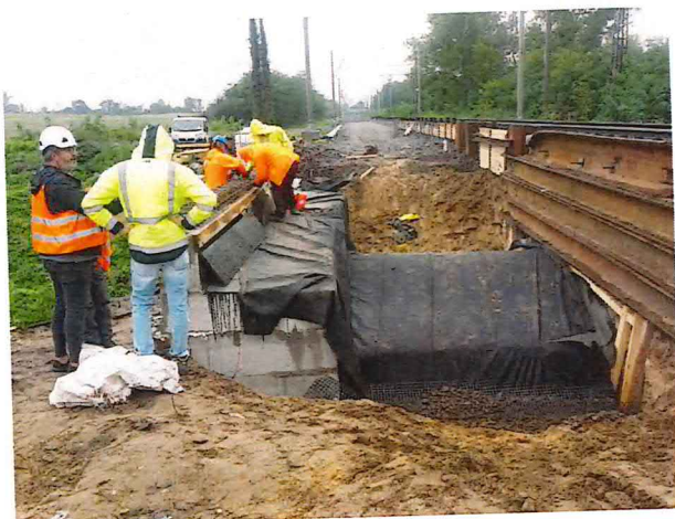
UČS 01, Armovanie, debnenie a betonáž rímsoy, prechodové oblasti, priepust 03
