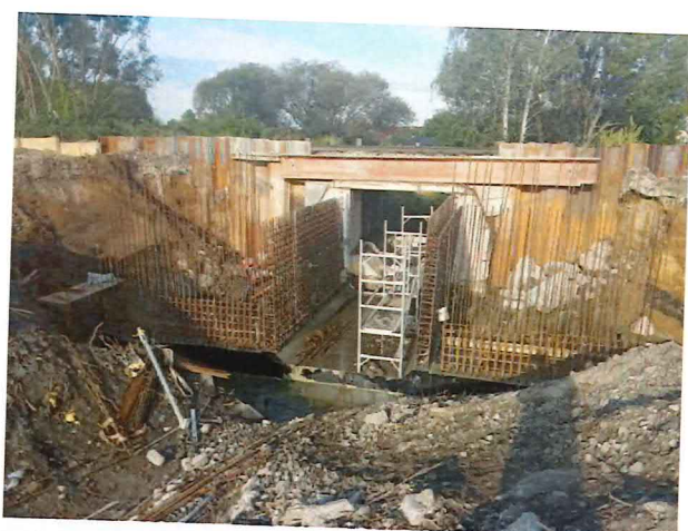
UČS 01, Armovanie debnenie a betonáž opôr, most 16
