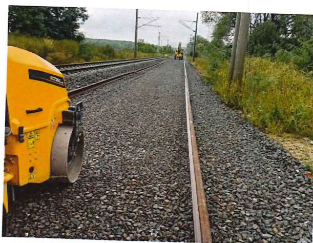
UČS 11, Hutnenie koľajového kameňa
