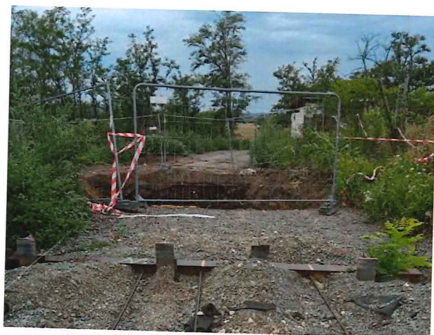
UČS 01, Štartovacia jama pre pretlak, prekládku vodovodu
